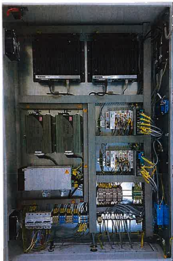
Fot. nr 2. Widok modułów wewnętrznych ZEW.NG-REDUNDANT. Źródło: CNBOP-PIB.
