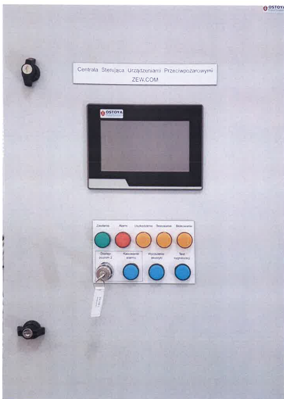
Fot. nr 1. Widok centrali typu ZEW.COM (drzwi z panelem dotykowym). Źródło: CNBOP-PIB.
