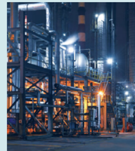
PKN Orlen Rafineria Trzebinia
