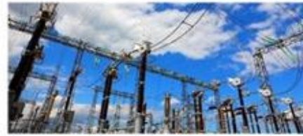
Mercedes-Benz Manufacturing Poland. Budowa stacji elektroenergetycznej WN/SN wraz z linią zasilającą 110 kV w ramach budowy fabryki.
