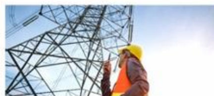
Tauron Dystrybucja. Budowa linii kablowej 110kV - SK 08 wraz z linią światłowodową pomiędzy GPZ Wieczysta - GPZ Mennicza.
