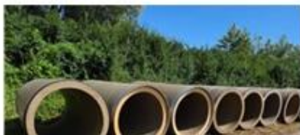
KGHM Polska Miedź S.A. Oddział Zakład Hydrotechniczny. Zasilanie Pompowni Tarnówek.
