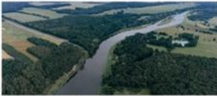
Komenda Główna Straży Granicznej. Budowa zabezpieczenia elektronicznego na odcinku rzeki Bug.
