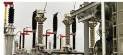
ME Stary Grodków. Budowa GPO i linii kablowej dla instalacji bateryjnego magazynowania energii Stary Grodków.
