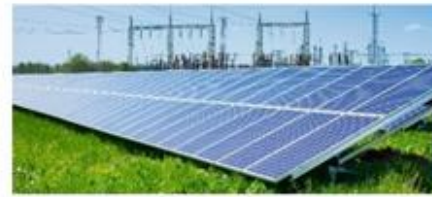
PSE. Rozbudowa rozdzielni 220 kV i 110 kV w stacji 220/110 kV dla przyłączenia BGP Adamów.
