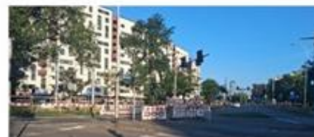
Gmina Wrocław. Remont torowiska na ul. Bardzkiej we Wrocławiu.
