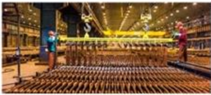
KGHM Polska Miedź. Modernizacja rozdzielnic i wymiana szyn w Hucie Miedzi Głogów.
