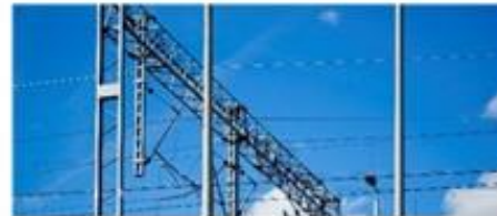
PGE Energetyka Kolejowa. Budowa podstacji trakcyjnej Wejherowo.
