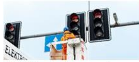
ZDIUM Wrocław. Konserwacja sygnalizacji świetlnej we Wrocławiu 2024-2025.
