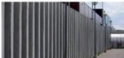
Stołeczny Zarząd Infrastruktury. Wymiana ogrodzenia wewnętrznego i zewnętrznego w Goławicach.
