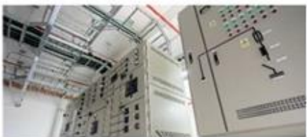
Polonez Plus. Instalacje elektryczne w ramach inwestycji Mercedes Benz w Jaworze.
